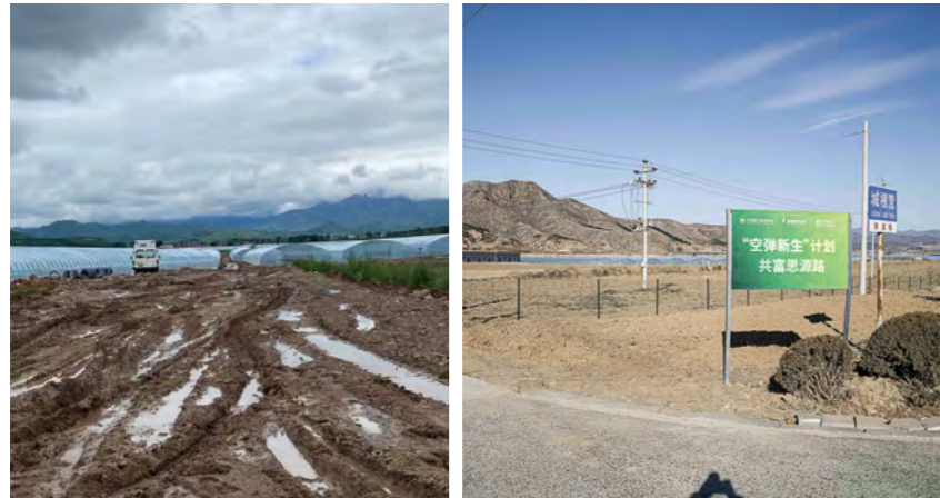
河北黄旗镇城根营村选瓜大棚前的道路原貌(左)、雾芯科技与中华思源工程扶贫基金会共同建成的“共富思源路”新貌(右)
